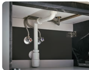
升級隱藏式排水管
